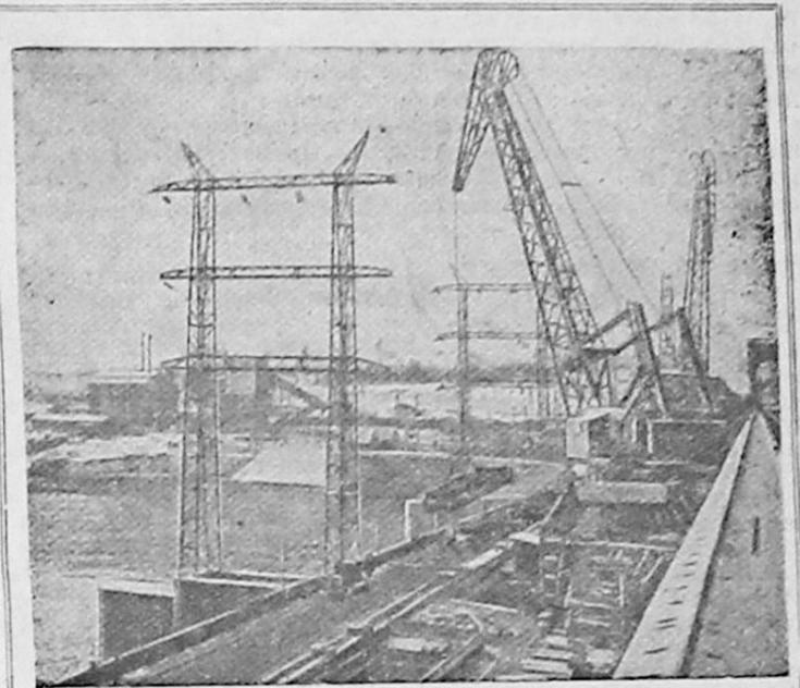
Камская ГЭС является не только крупной стройкой, но и действующим предприятием, вырабатывающим электроэнергию. На полную мощность работают 5 первых турбогенераторов ГЭС. Недалеко то время, когда все 24 агрегата станут на службу народному хозяйству. На снимке: на участке строительства плотины. Фото Б. Визуля.
